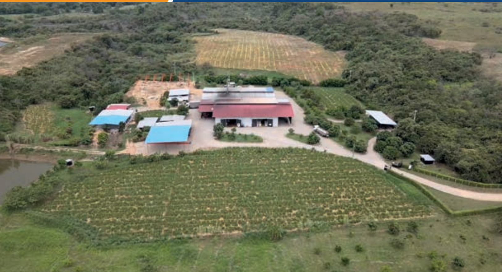
Vista de las instalaciones de Harinas Cárnicas del Huila.
