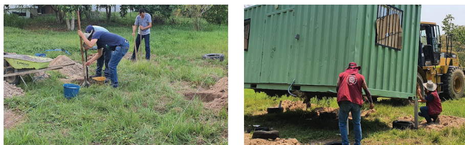
Figura 17. Adecuación del terreno e instalación de la planta piloto
