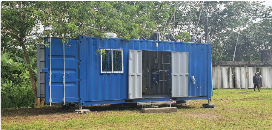
Figura 13. Planta piloto de biogás implementada en el municipio de Tumaco que trata residuos de pesca artesanal
