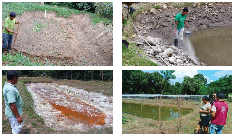
Figura 4. Retiro de lodos, encalado y verificación de enmallado superior y perimetral de estanques Fuente: elaboración propia.
